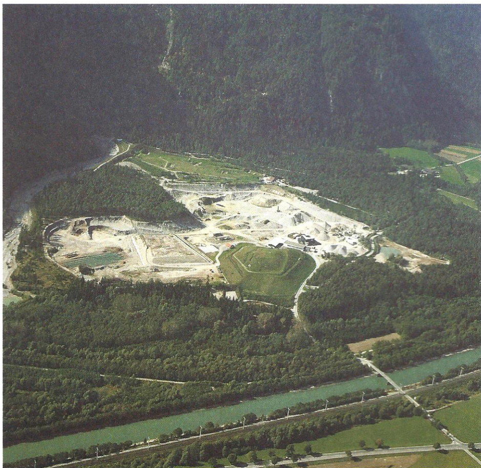
Bild 27: Gesamtansicht des Lavanter Forchach, Richtung Südwesten. Schottergrube, Mülldeponie und Schießanlage des Bundesheeres, rechts angrenzend der intakte westliche Föhrenwald, dahinter der Weiler „Lavant-Wacht“. Unten im Bild die Drau.
