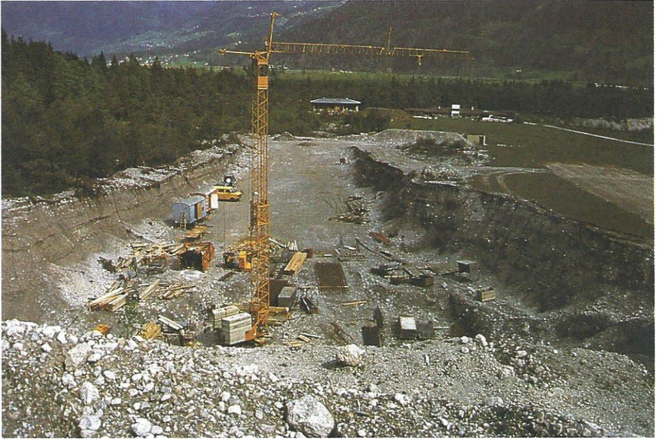
▲ Bild 24: Intensive Bautätigkeit des Bundesheeres im Jahre 1991: Errichtung einer Schießanlage im Föhrenwald; entsprechend nachhaltig waren die Schäden an der Natur:
